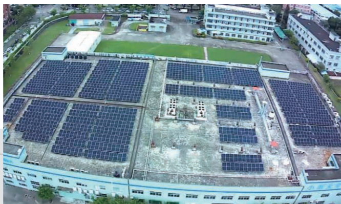
在工厂屋顶安装太阳能板
